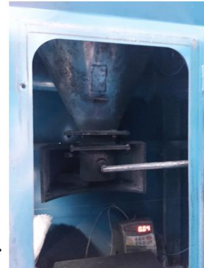
Cabine de pesagem (parte interna)
